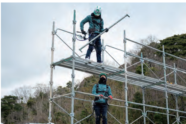
足場工事で活躍するインドネシア人実習生
