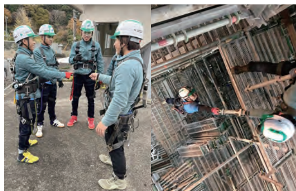
足場作業の様子
